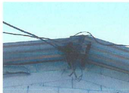
Foto 4: Se requiere mejoramiento del sistema eléctrico de la escuela para evitar algún siniestro.
